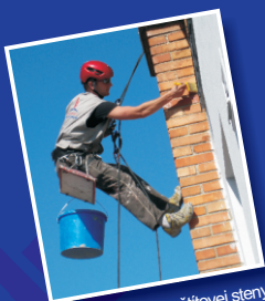
Sanácia komína a šítrovej steny - budova Britskej ambasády
