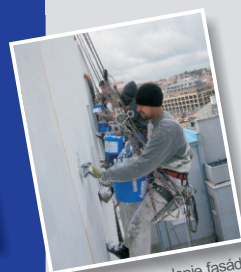
Zateplenie fasády - Hotel Tatra Bratislava
