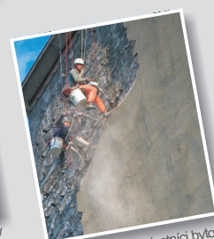
Sanáčnne práce - vlastníci bytov a NP Skenárovova 34 - 36, BA
