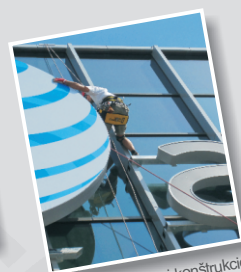
Montáž reklamnej konštrukcie - budova Lakeside Park
