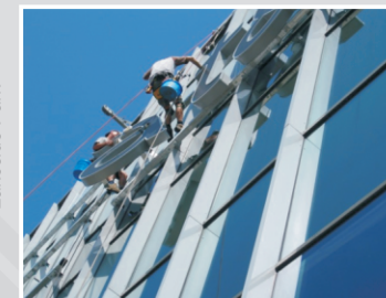
Montáž reklamnej konštrukcie - Lakeside Park
